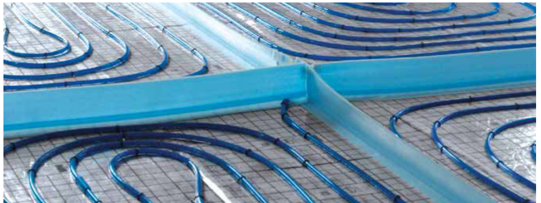
Att. 14. Apkures laukumu sadalījums ar kompensācijas šuvēm
