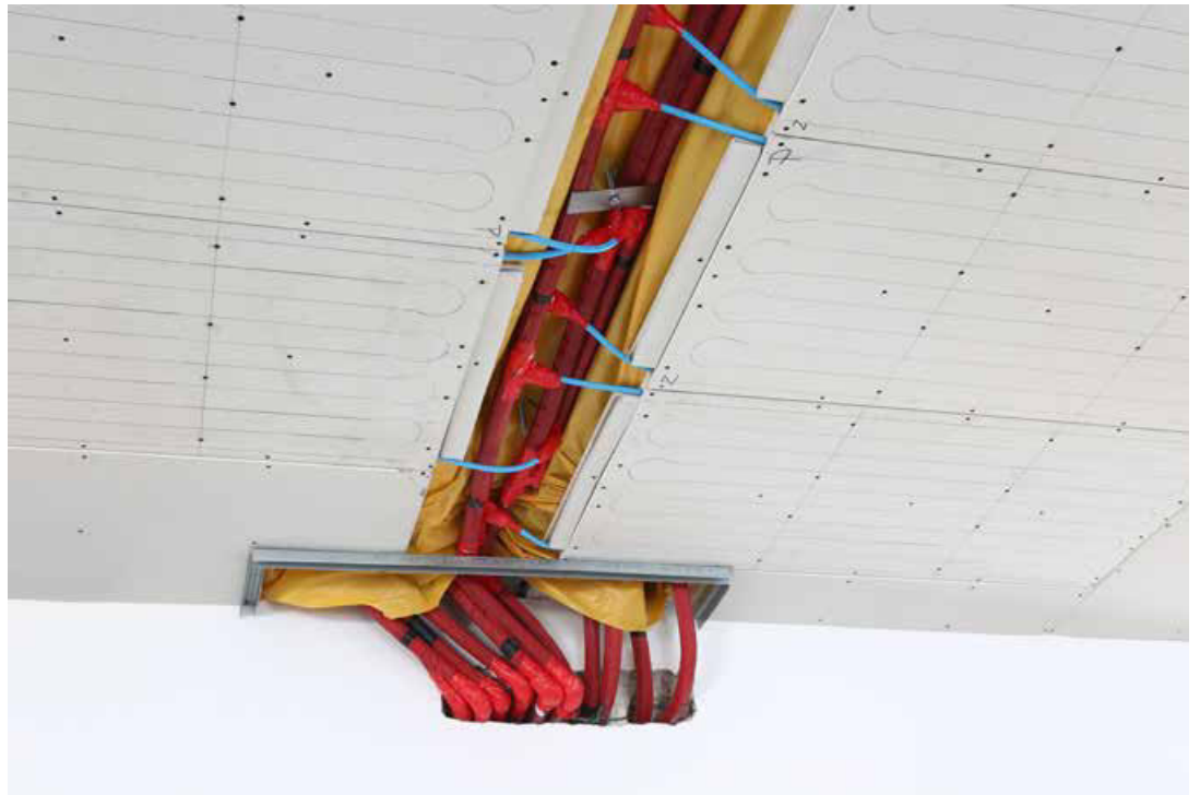
Att. 6. Griestu dzesēšanas sistēmas uzstādīšanas ar sistēmas KAN-therm Wall apsildes un dzesēšanas plākšņu izmantošanas.
