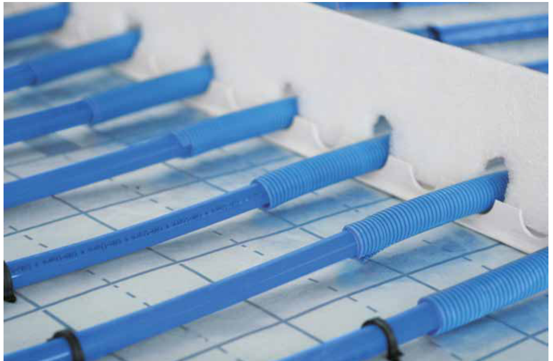
Att. 17. Kompensācijas profils - tranzīta cauruļu izvietošana caur kompensācijas šuvēm
