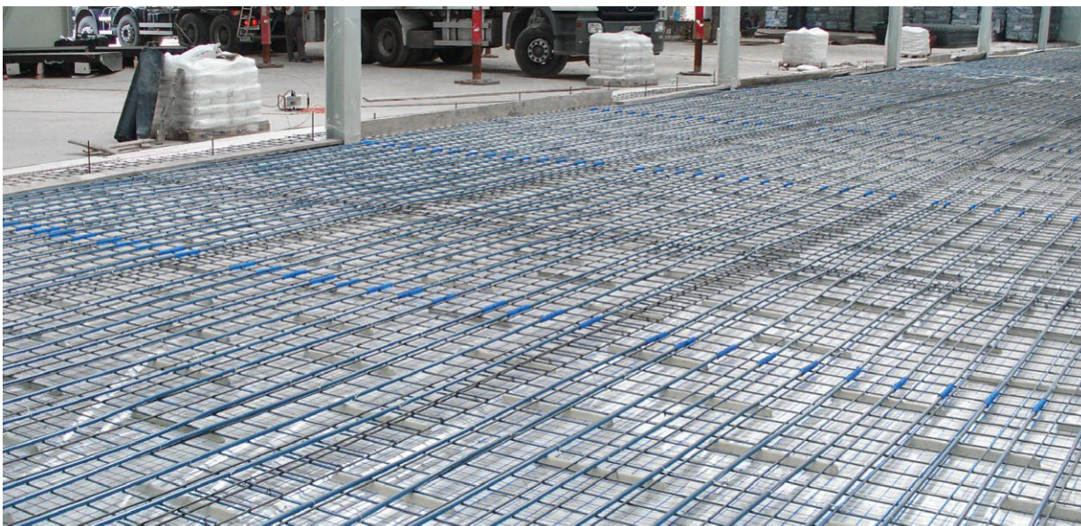
Att. 4. Grīdas apsildes sistēma noliktavā, izmantojot bluePERT un KAN-therm NET Sistēmas caurules.
