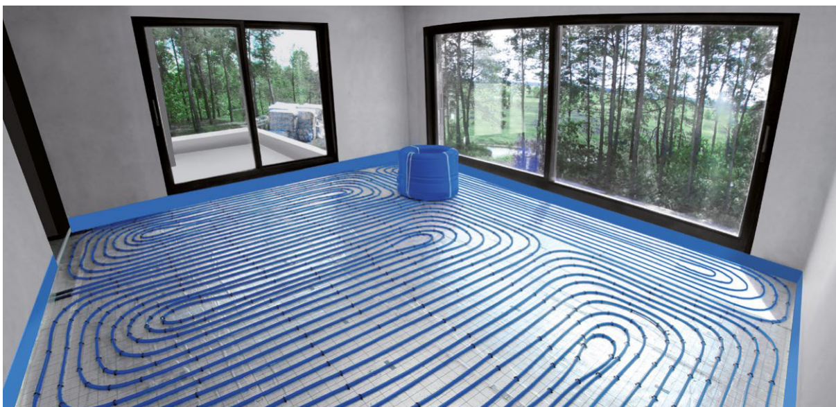
Att. 3. Grīdas apsildes sistēma vienas ģimenes mājokļos, izmantojot bluePERT un KAN-therm Tacker Sistēmas caurules.
