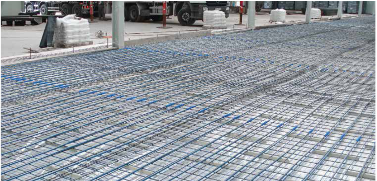
Att. 4. Grīdas apsildes sistēma noliktavā, izmantojot bluePERT un KAN-therm NET Sistēmas caurules.
