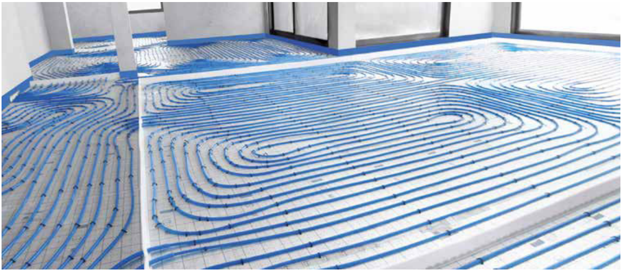
Fig. 25. Grīdas apsildes/dzesēšanas sistēmas uzstādīšana, izmantojot KAN-therm Tacker sistēmu.
