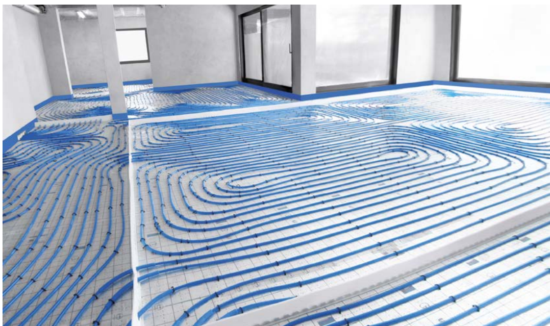
Att. 24. KAN-therm Tacker grīdas apkures sistēma
