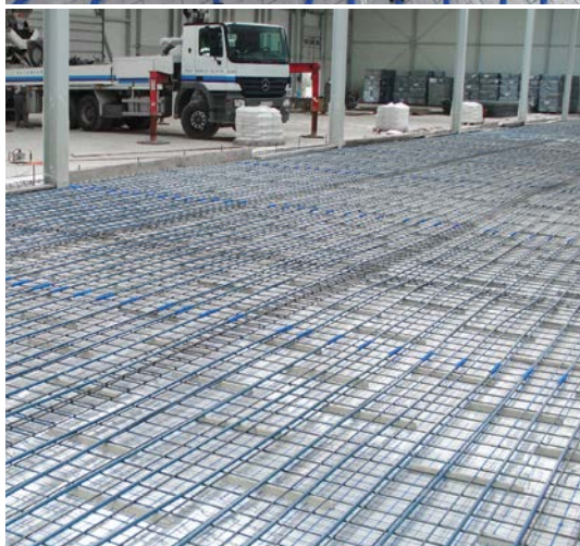
Att. 4. Grīdas apsildes sistēma noliktavā, izmantojot PE-RT Blue Floor un KAN-therm NET Sistēmas caurules.
