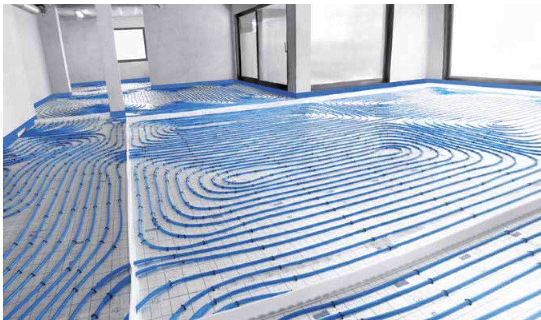
Att. 24. KAN-therm Tacker grīdas apkures sistēma
