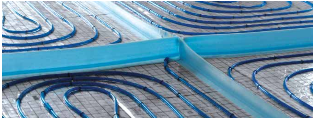
Att. 13. Apkures laukumu sadalījums ar kompensācijas šuvēm
