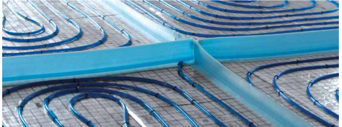
Att. 13. Apkures laukumu sadalījums ar kompensācijas šuvēm
