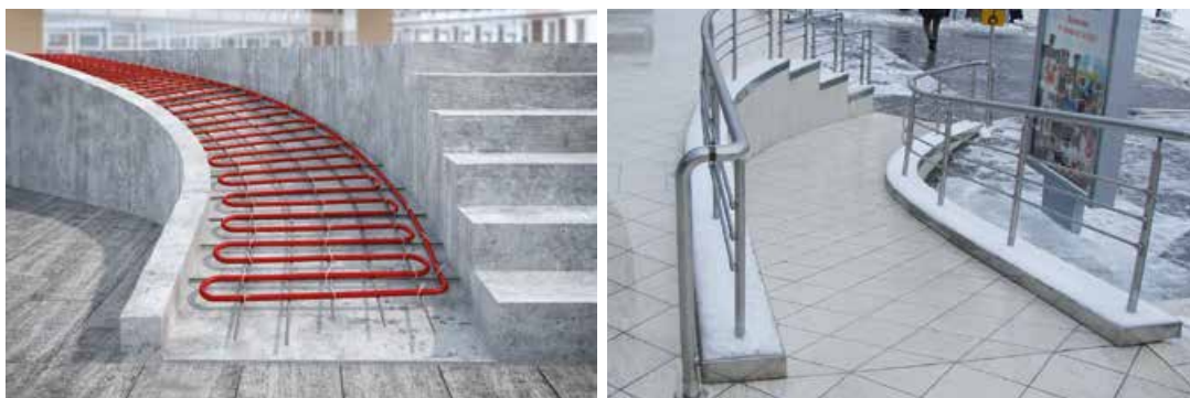
Att. 35. Ārējo virsmu apsilde KAN-therm – darbu laikā un pēc tam
